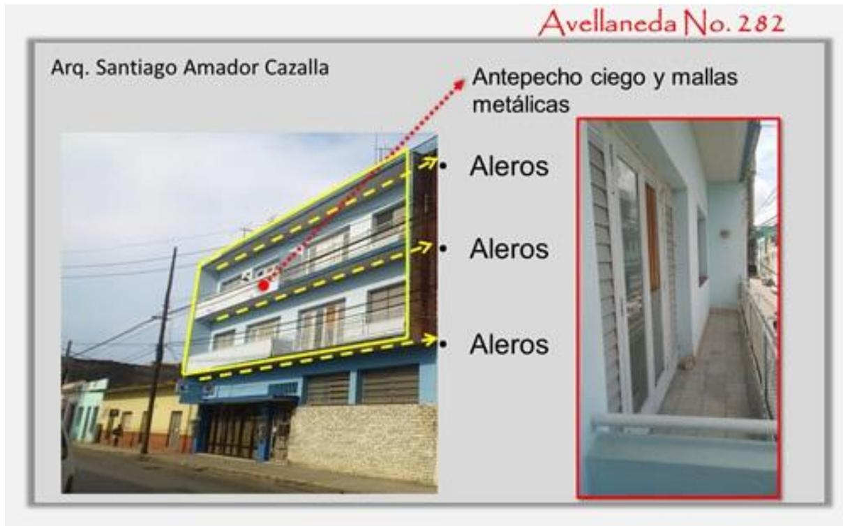
Fig. 8 Geometría de la fachada, con función de protección ambiental
